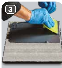
3 Application de la résine époxy 3X sur le ROLLERKIT®
