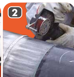
2 Preparación superficial Sa2½ / Sf3 y rugosidad Rz > 60 µm
