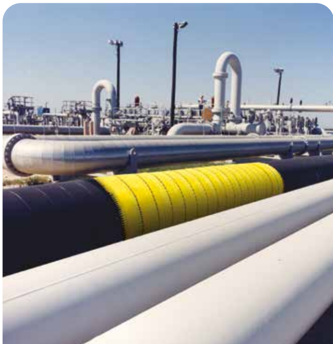
REPARACIÓN Y REFUERZO DE TUBERÍAS De acuerdo a ISO 24.817 y ASME PCC-2
